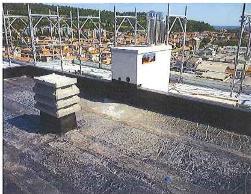
foto n.° 24 (Visita n.2 del 17.07.2012) – membrana impermeabile presente su i solai di copertura della torre "D", risvoltata sulle velette perimetrali e/o sulla canna fumaria.
