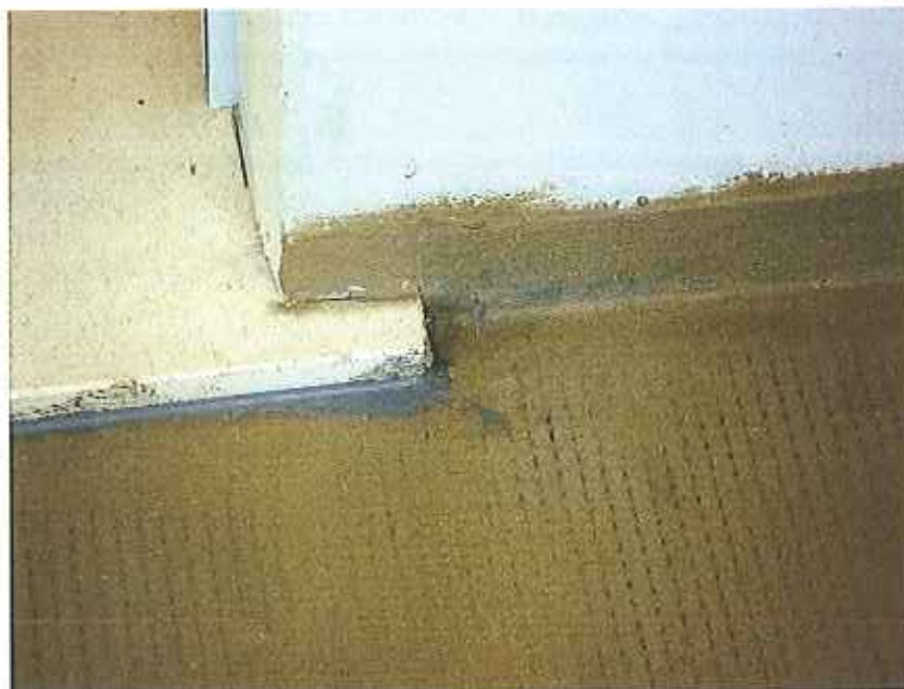
foto n.° 19 (Visita n.2 del 17.07.2012) – particolare della realizzazione della impermeabilizzazione di una terrazza della torre "D" con sistema Kerakol acqua Expert.
