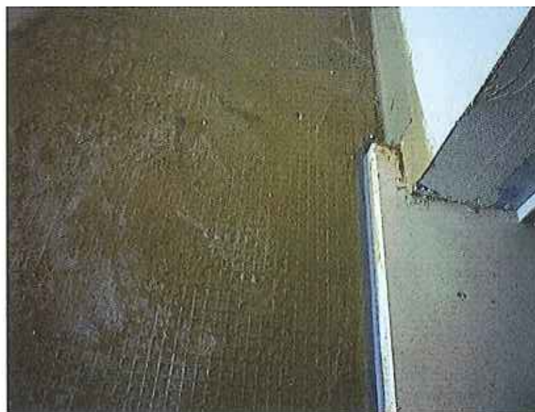
foto n.° 16 (Visita n.2 del 17.07.2012) – particolare della realizzazione della impermeabilizzazione di una terrazza della torre "D" con sistema Kerakol acqua Expert.
