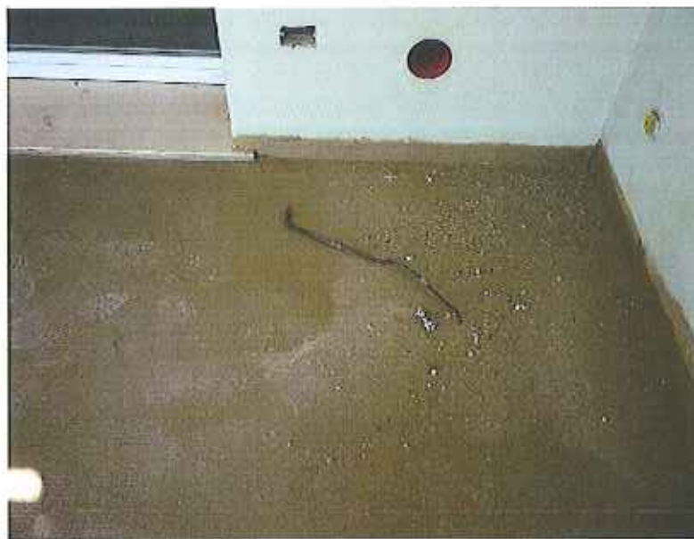
foto n.° 17 (Visita n.2 del 17.07.2012) – massetto impermeabilizzato e pronto per accogliere la pavimentazione.
