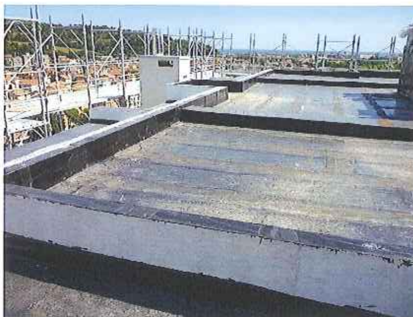
foto n.° 22 (Visita n.2 del 17.07.2012) – membrana impermeabile presente su i solai di copertura della torre "D", risvoltata sulle velelle perimetrali.
