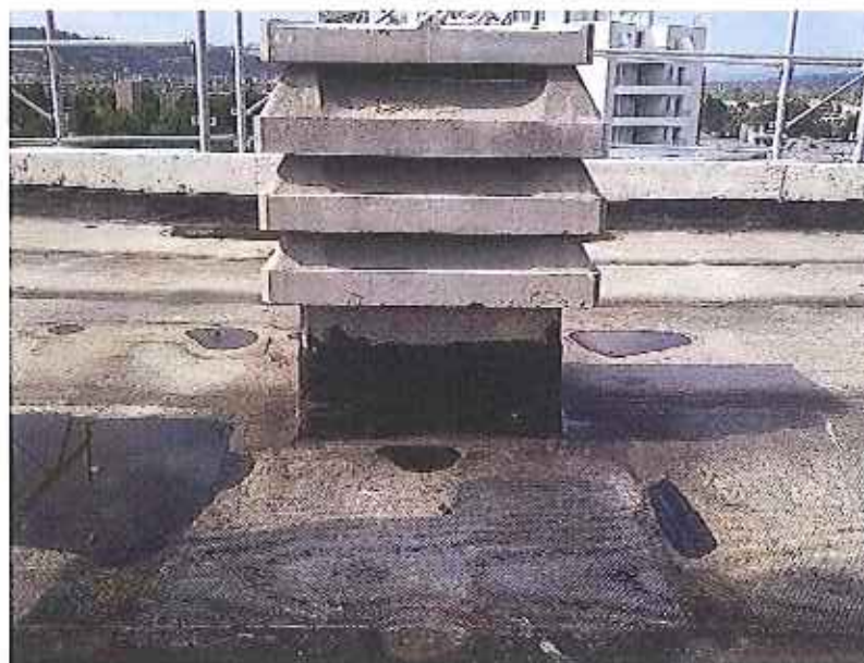
foto n.° 13 (Visita n.1 del 02.05.2012) -particolare del risvolto sulla veletta perimetrale e sulla canna fumaria del primo strato di membrana impermeabile presente sul solaio di copertura della torre "D".
