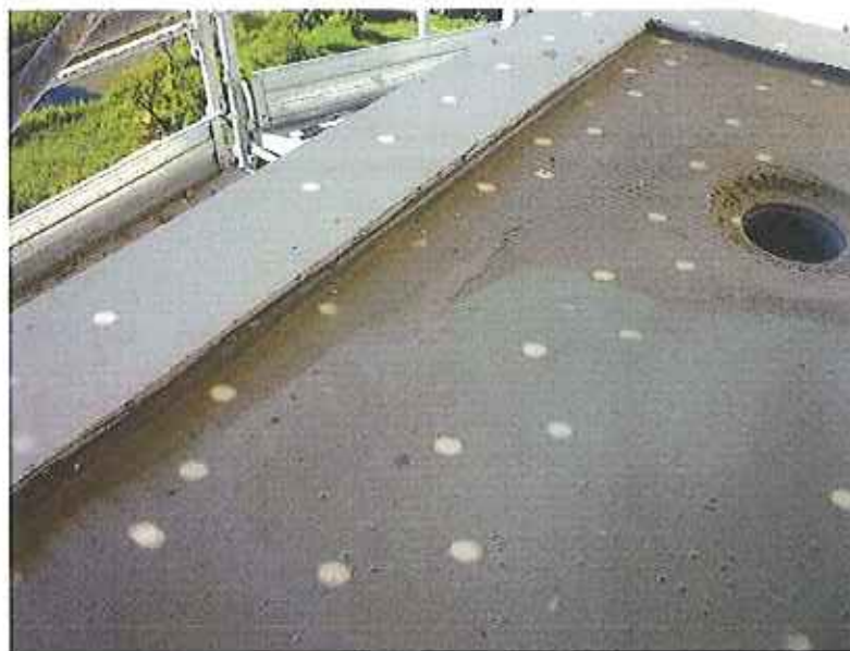
foto n.° 15 (Visita n.2 del 17.07.2012) – particolare pilella di raccolta acque meteoriche terrazza torre "D".
