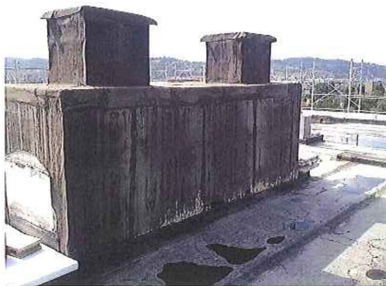
foto n.° 14 (Visita n.1 del 02.05.2012) – particolare del risvolto su un torrino del primo strato di membrana impermeabile presente sul solaio di copertura della torre "D".
