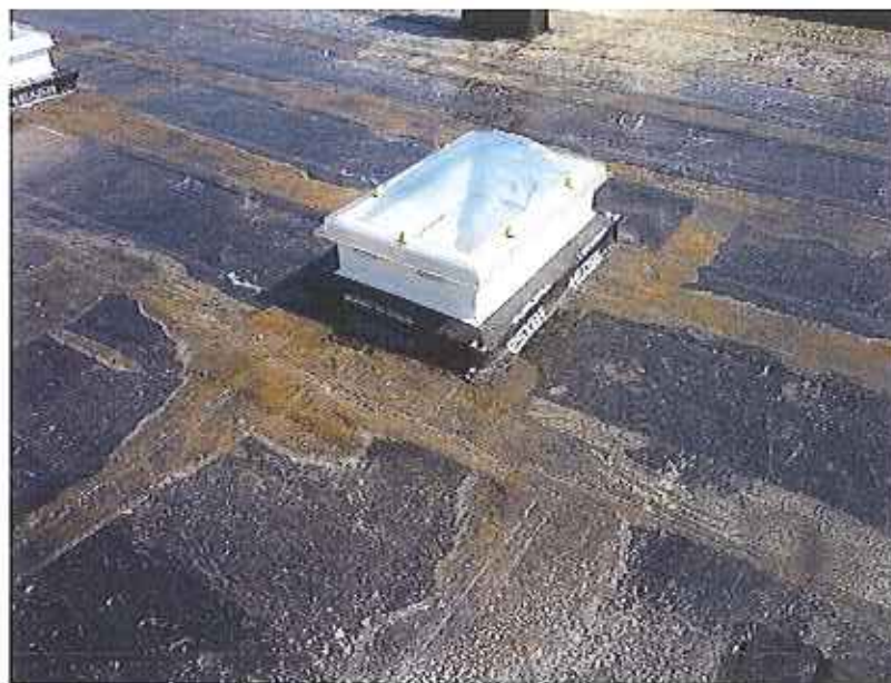
foto n.° 23 (Visita n.2 del 17.07.2012) – membrana impermeabile presente su i solai di copertura della torre "D", risvoltata sui lucernai.
