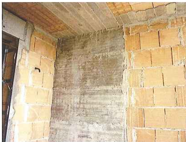
foto n.° 4 (Visita n.1 del 02.05.2012) – vista del calcestruzzo di un setto e di una trave della torre "D".
