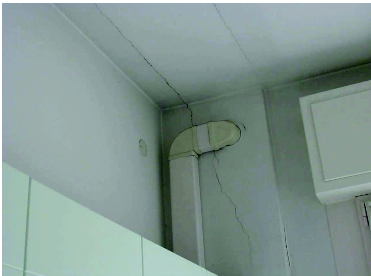
Foto 2. Fessure in corrispondenza della canna fumaria e del solaio di sottotetto in cucina
