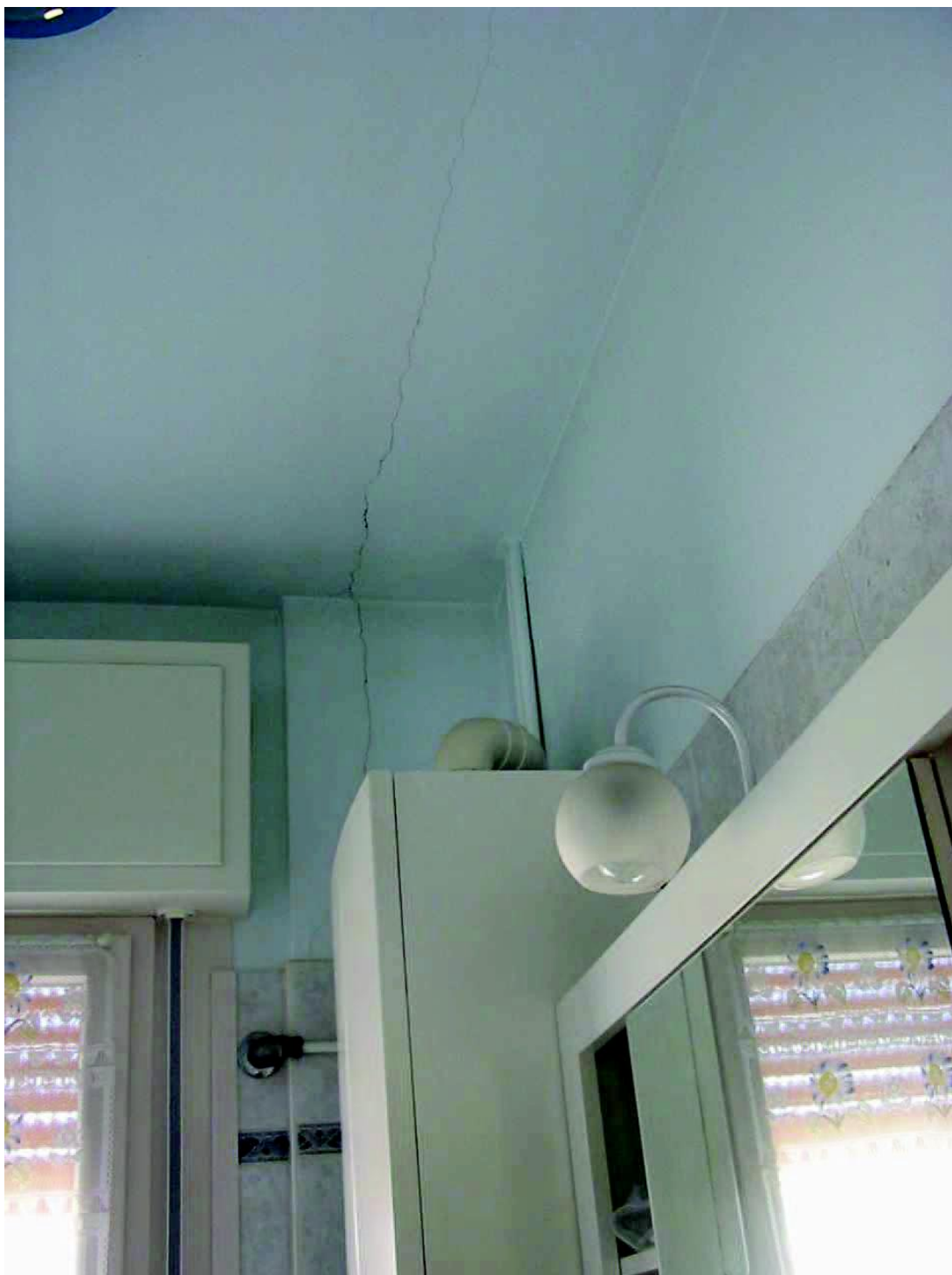
Foto 3. Fessure in corrispondenza della canna fumaria e del solaio di sottotetto in bagno
